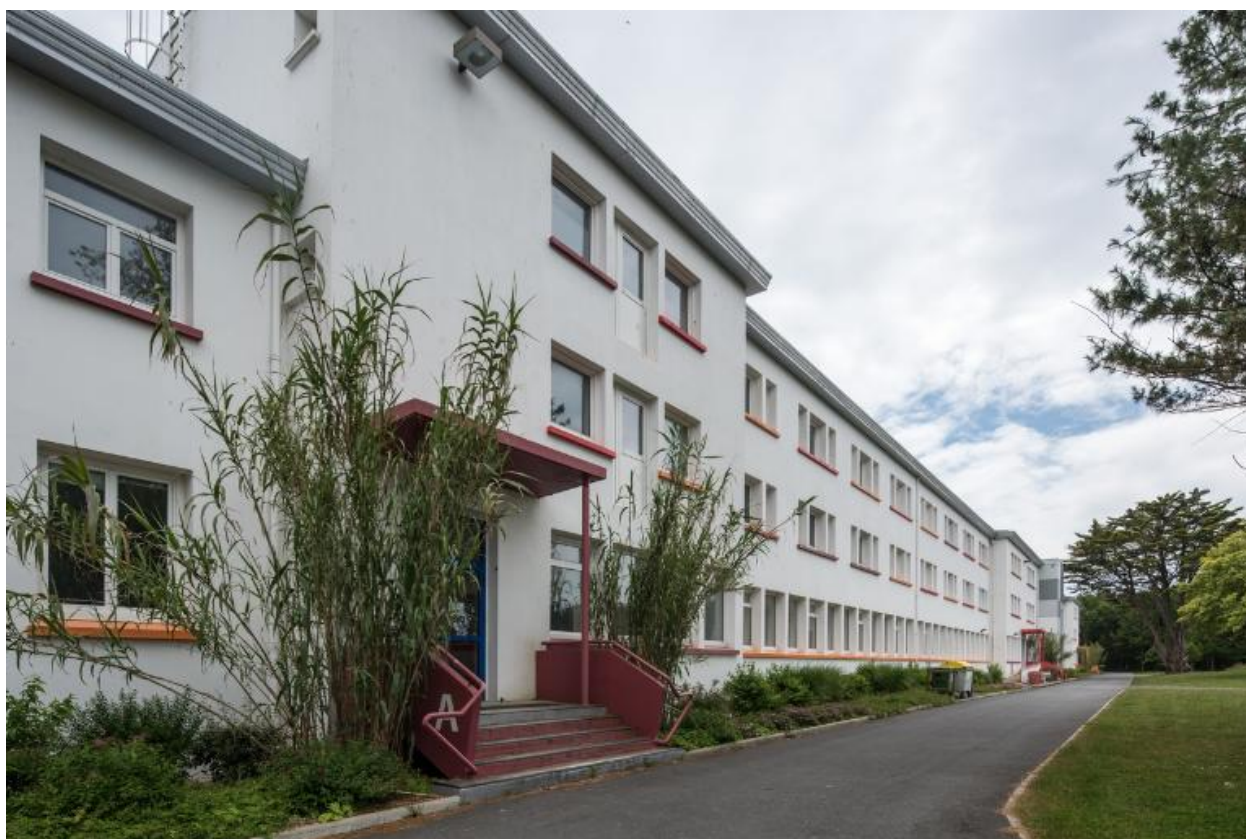
Vue d'ensemble de la façade ouest de l'internat des filles. Henri Riedberger, architecte, 1958.
