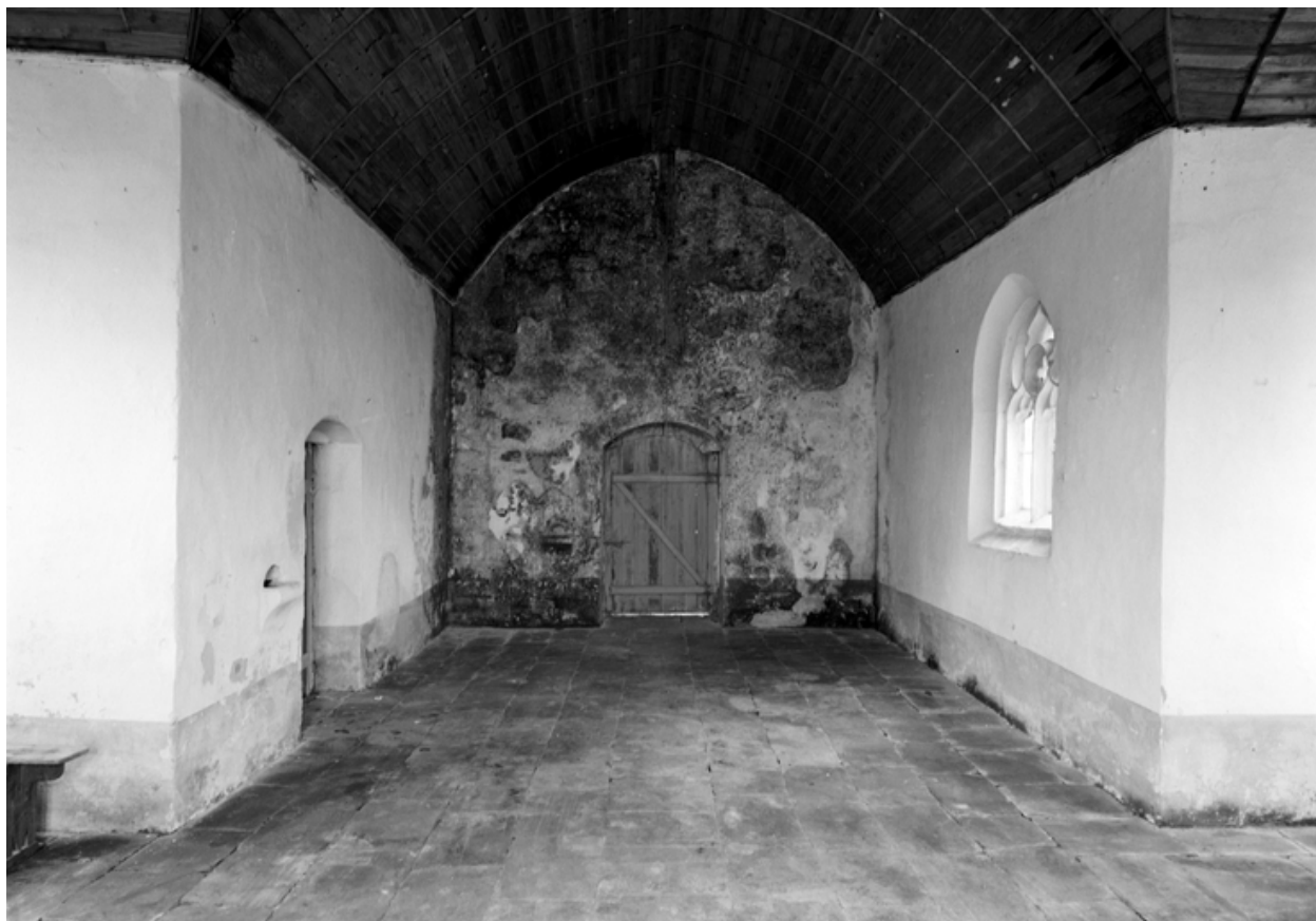
Vue de la nef vers l'ouest
