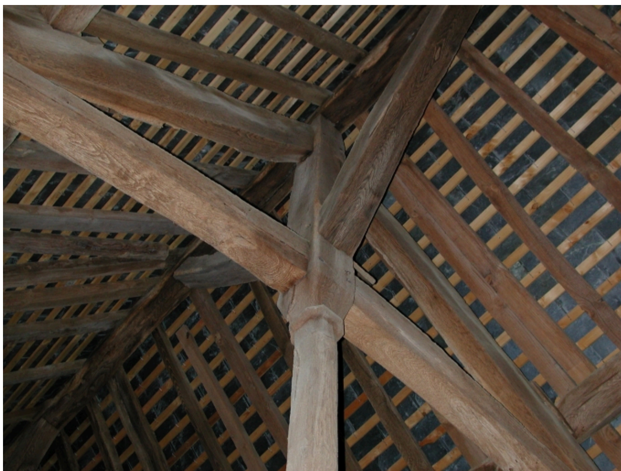
Charpente ; poinçon, partie haute
