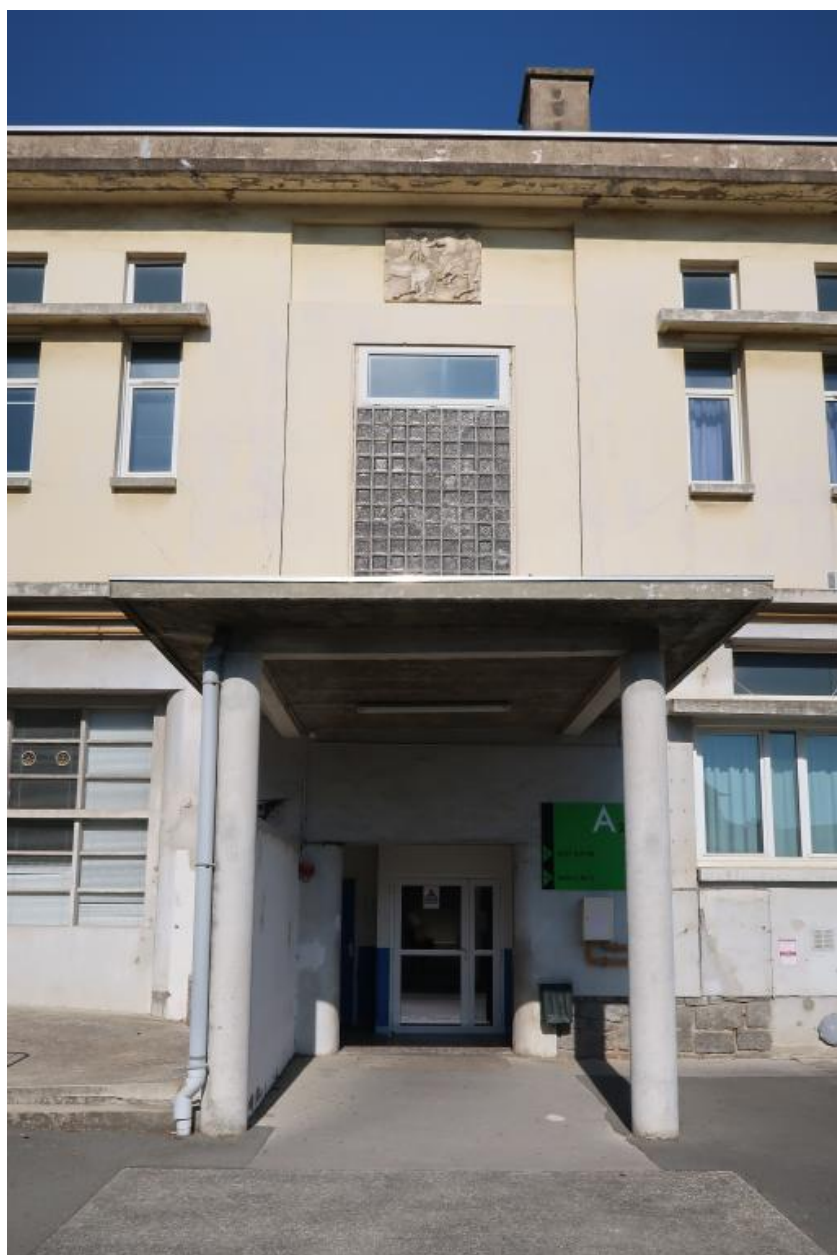
Détail sur l'une des entrées du bâtiment A (G-R. Lefort, architecte, 1934).
