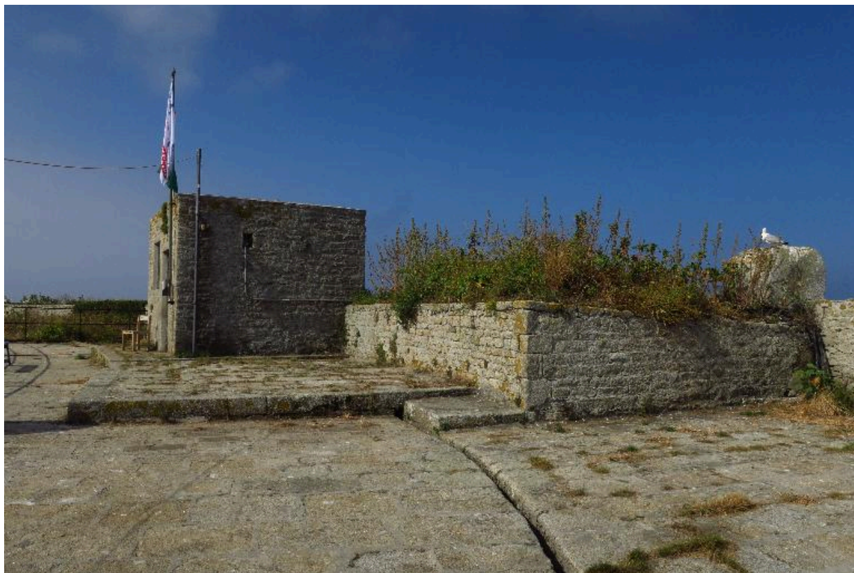
Archipel de Glénan, fort de l'île Cigogne, batterie Ouest, vue d'ensemble.
