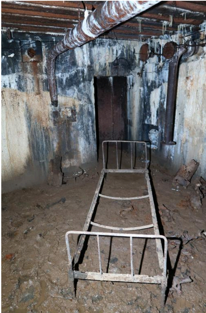
Vue de la pièce de vie - chambre de troupe : lit, porte étanche, tuyau du système de ventilation et tuyau d'évacuation du poêle (le poêle a été pillé il y a une quinzaine d'année), clapet/bouche de surpression du sas (état au 11 octobre 2022)
