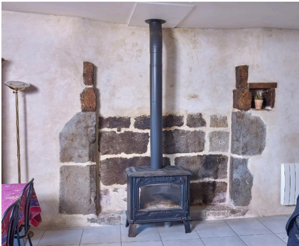
Logis nord. Vestiges de la cheminée sur le mur de refend. Vue générale
