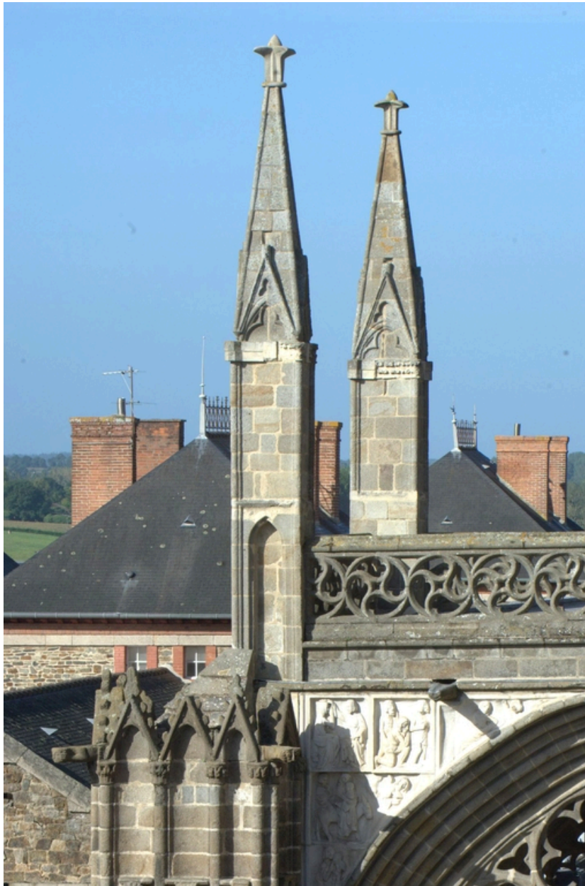
Porche sud, face est, détail contreforts et pinacles
