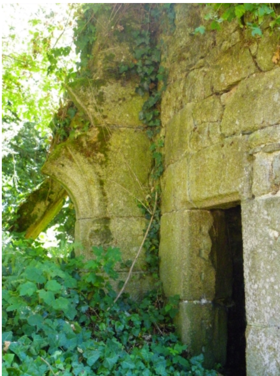
Ancienne baie trilobée.
