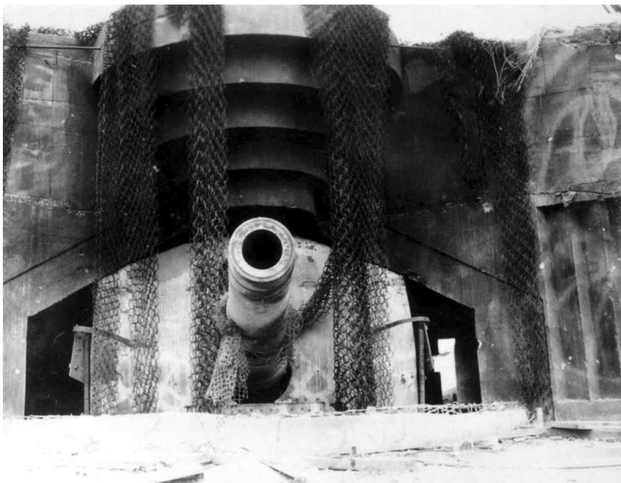
Vue d'un canon sous casemate de la batterie lourde codée M.K.B. Graf Spee (4 canons de 280 mm) (Re 303) (5 / M.A.A. 262), septembre 1944 (U.S. Army Signal Corps). Devant l'affût du canon, filets de protection en chaîne
