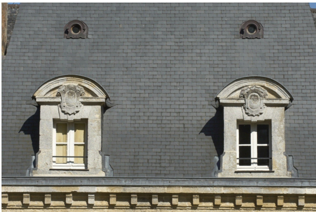
Logis, façade arrière, pavillon central, lucarnes
