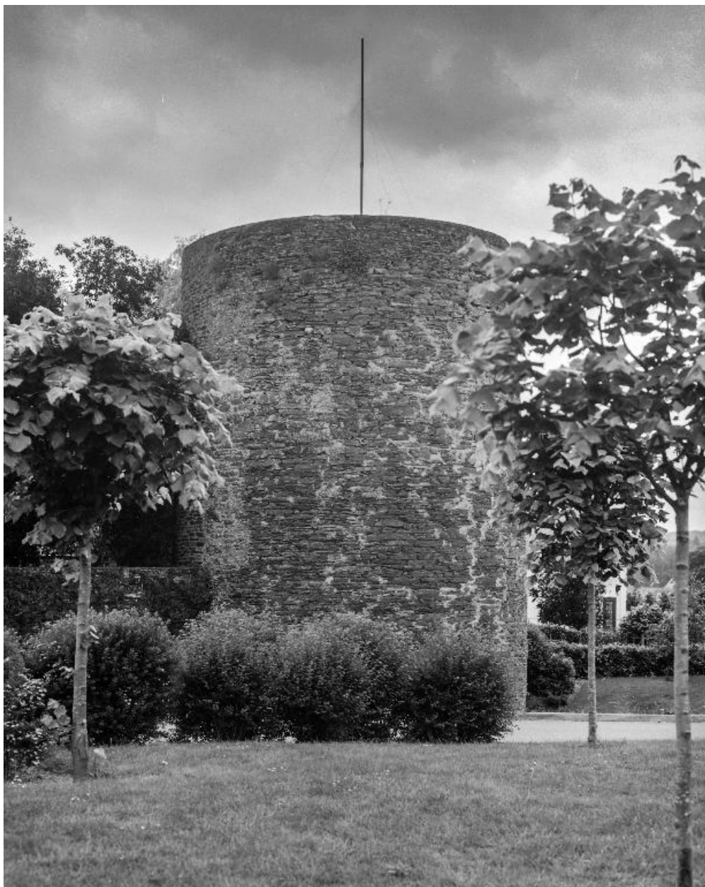
Fortification d'agglomération : rue Mystringue (état en 1985)
