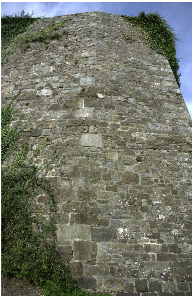
Vue du fort de Lanvéoc : demi-bastion de l'extrémité est, détail du liaisonnement du parement. Chaîne en granite
