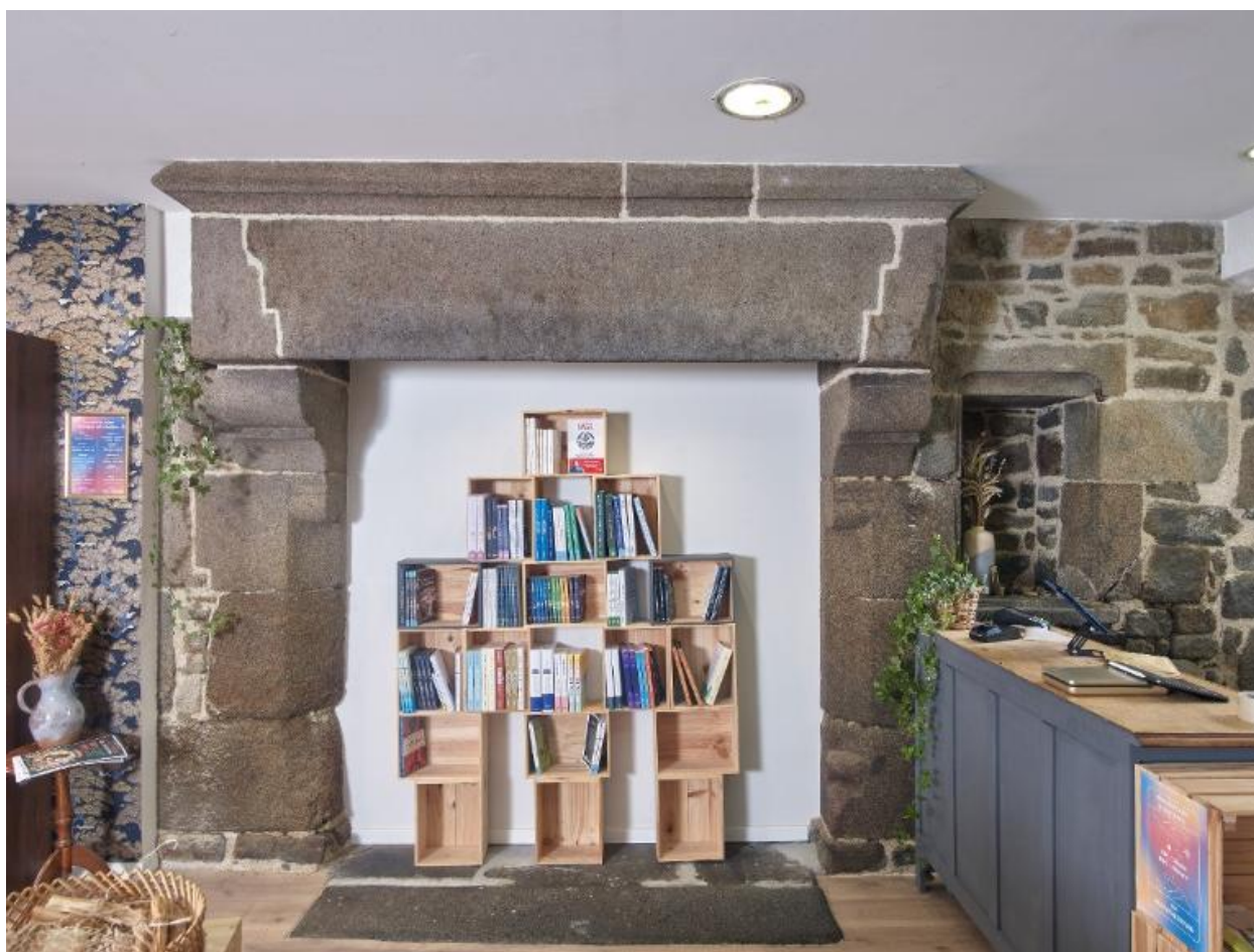
Cheminée du rez-de-chaussée avec piédroits chanfreinés et corbeaux moulurés.
