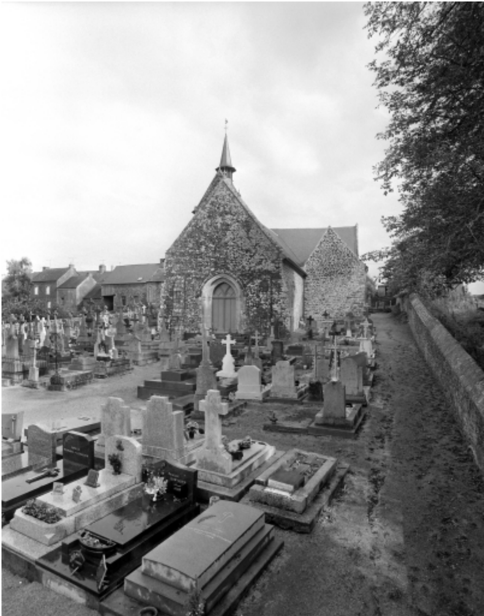
Elévation Ouest : vue générale
