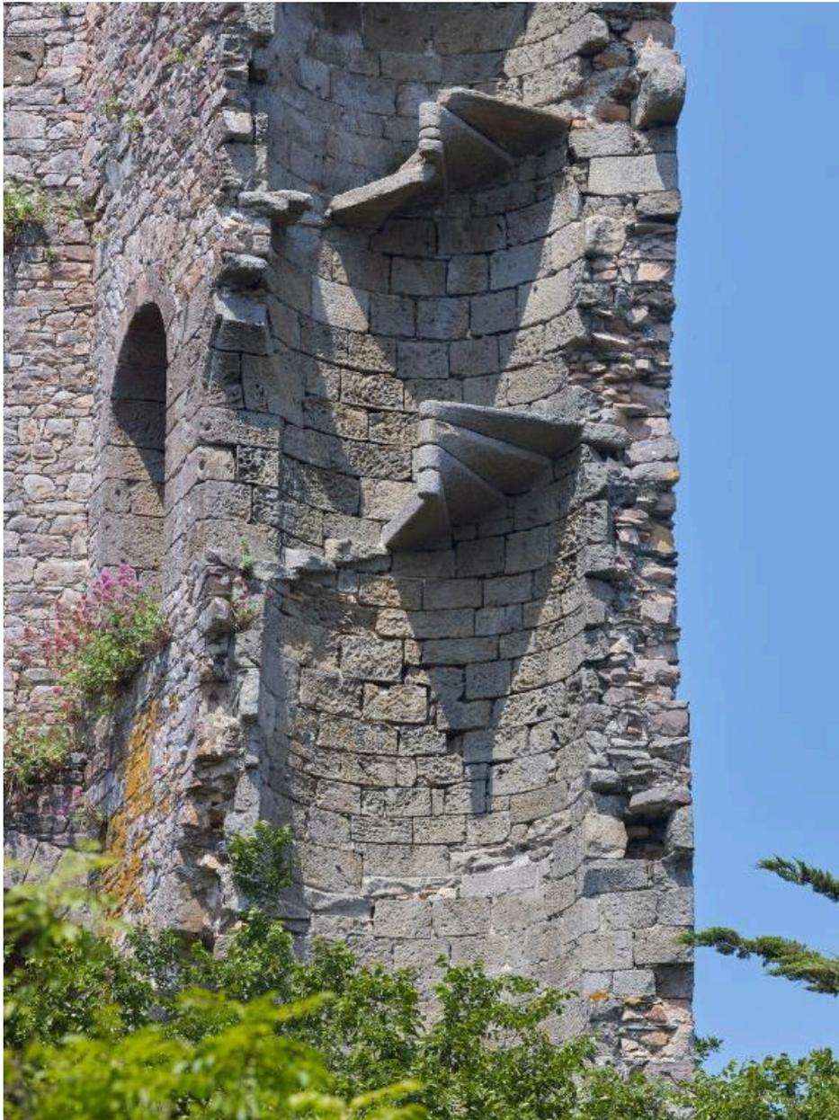
Vue de l'escalier en vis au niveau des 1er et 2ème étages. On observe des marches arrachées lors de l'explosion...
