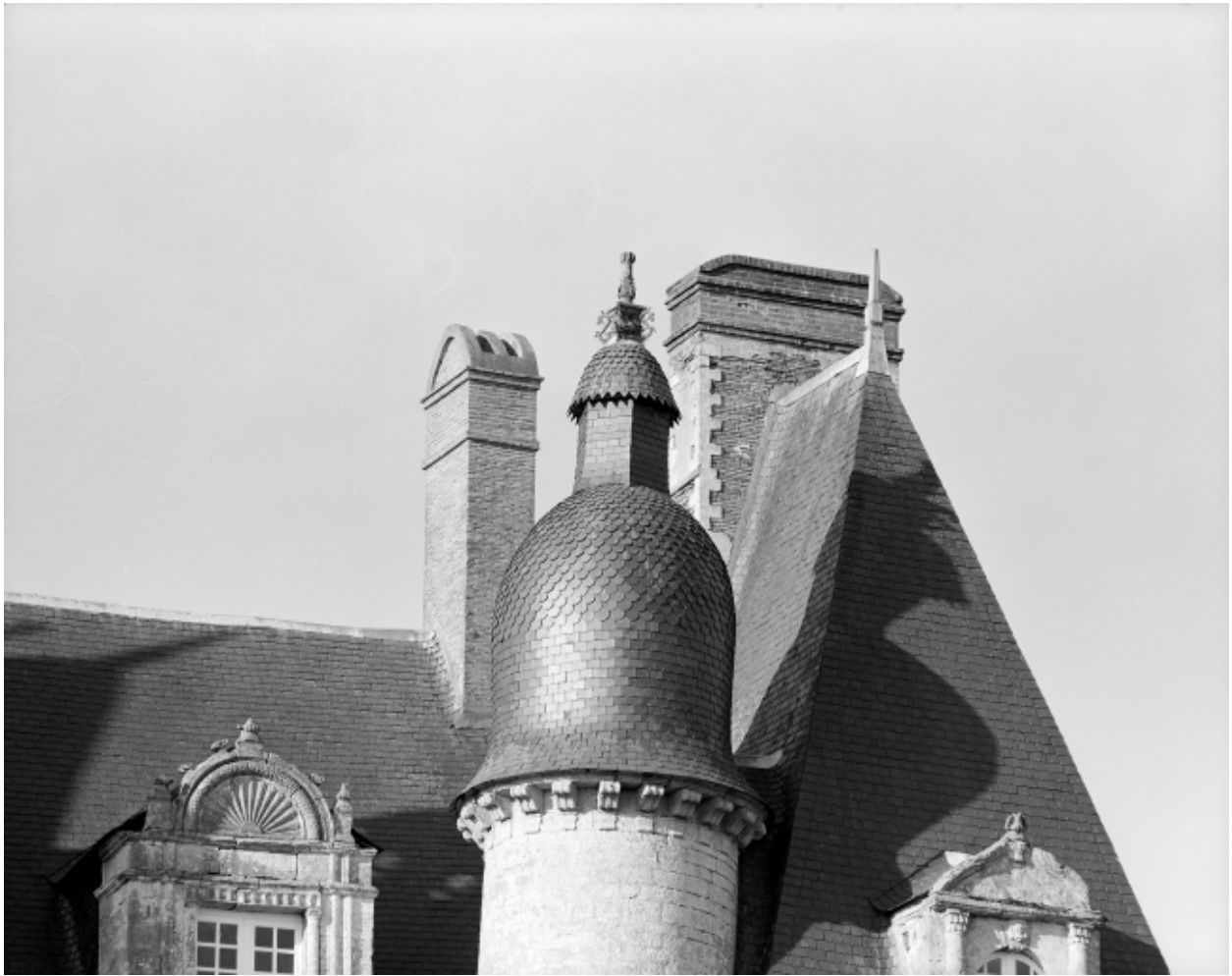
Pavillon ouest : toits et cheminées, vue générale.
