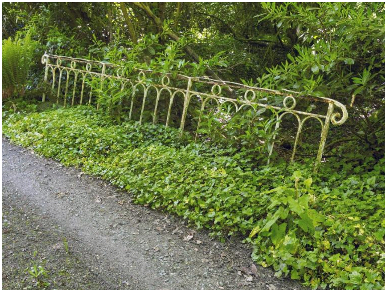
Garde corps du ha-ha
