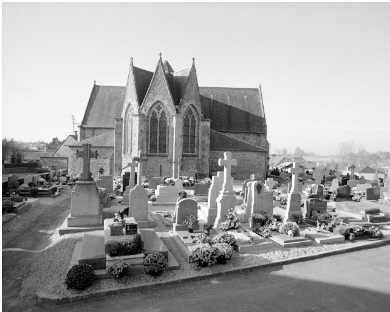
Elévation Est : vue générale
