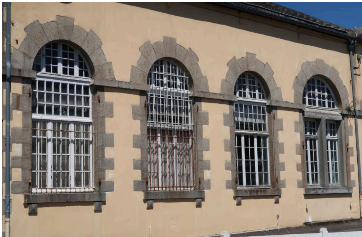
Vue de détail de l'élévation sud (état en 2022)
