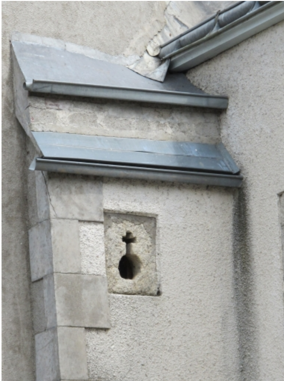
Logis, vue arrière, détail, bouche à feu
