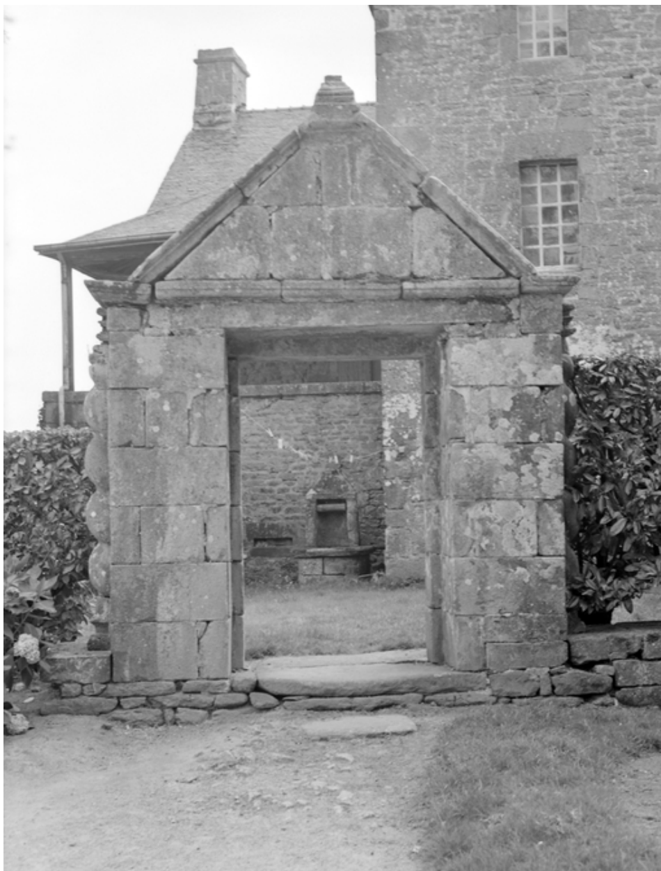
Portail nord et puits.
