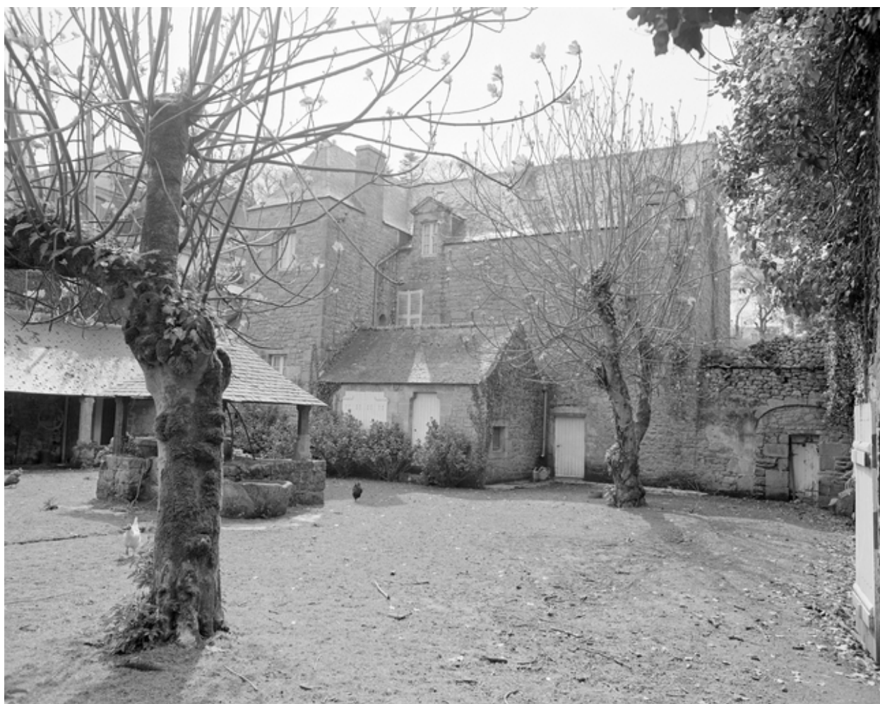
Logis abbatial, élévation est. Vue prise de la cour. (1983)
