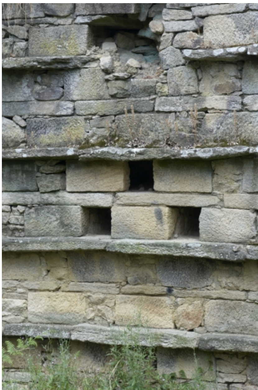
Colombier, vue intérieure
