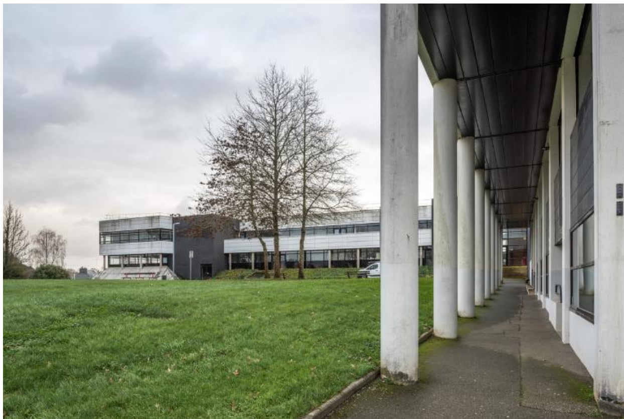
Ailes nord et ouest du bâtiment multifonctions : façades et galerie. Philippe Brulé et Marc Quéré, architectes, 1997.
