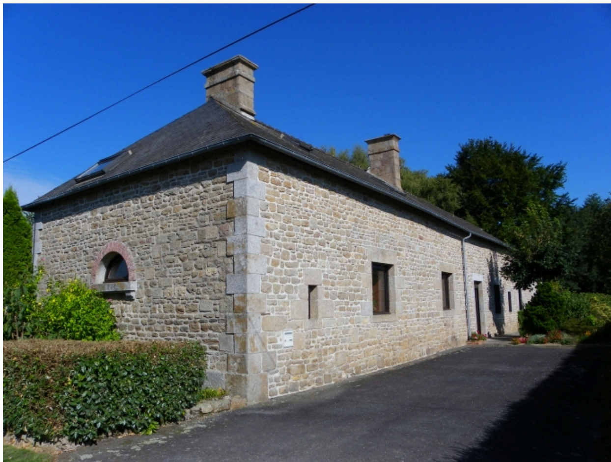
Communs est, façade est.
