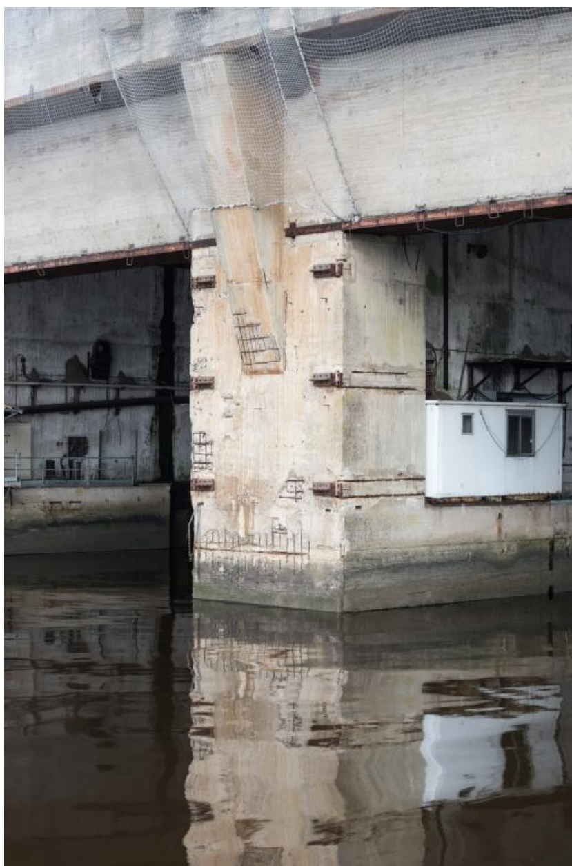
Vue de détail du front ouest : mur de refend des alvéoles
