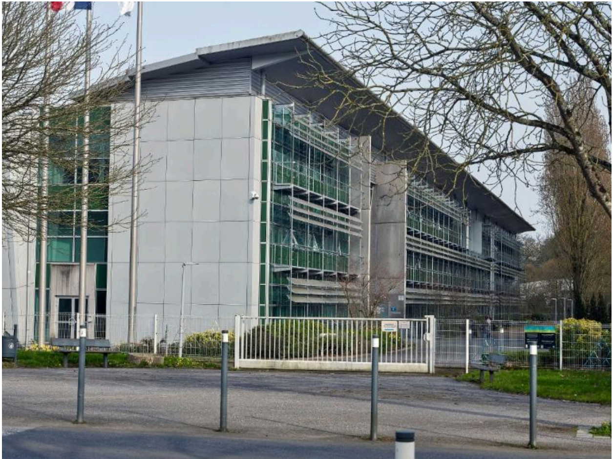
Vue d'ensemble de la façade sud. Joël Y. Gautier, architecte, 1992.
