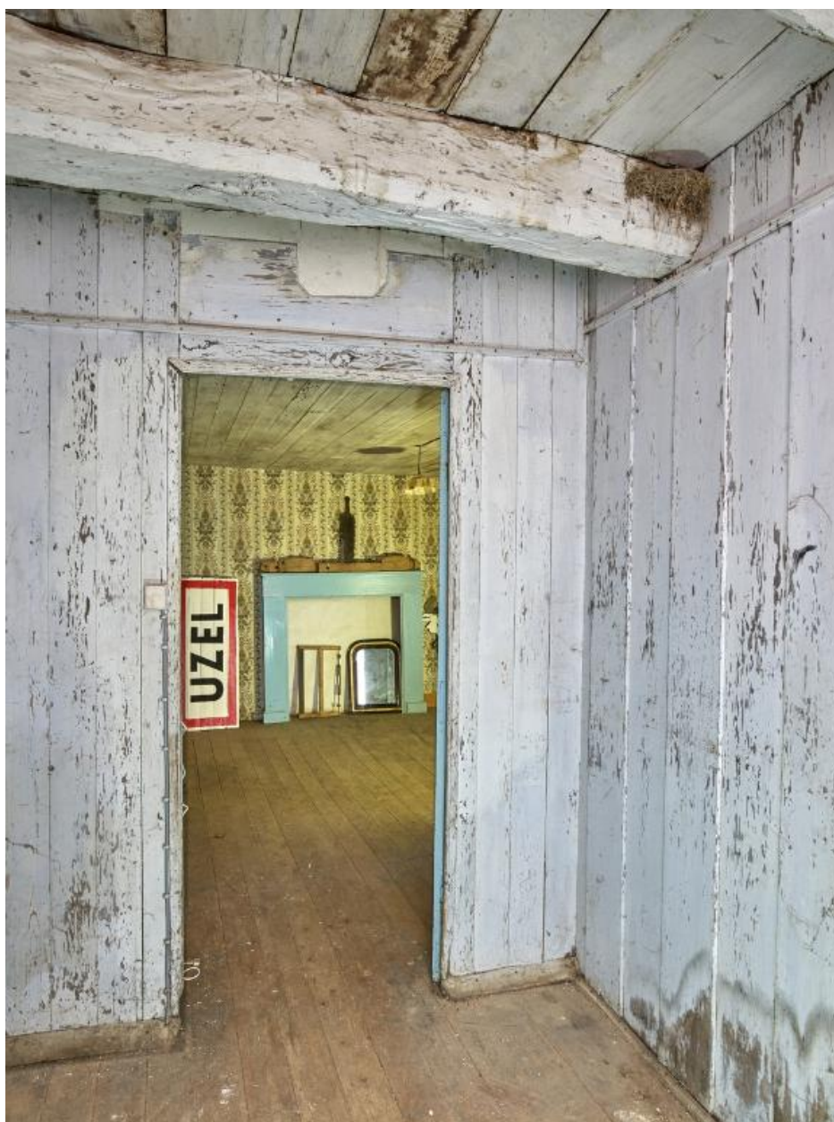
Logis 1673. Etage. Cloisons en bois posées au 19e siècle pour diviser l'étage en deux pièces. Vue sur la chambre à feu
