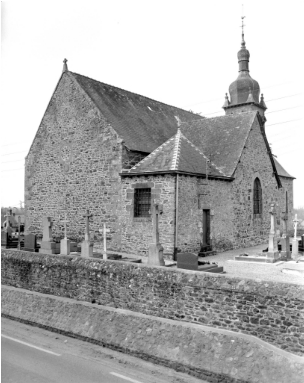
Elévation Est : vue générale
