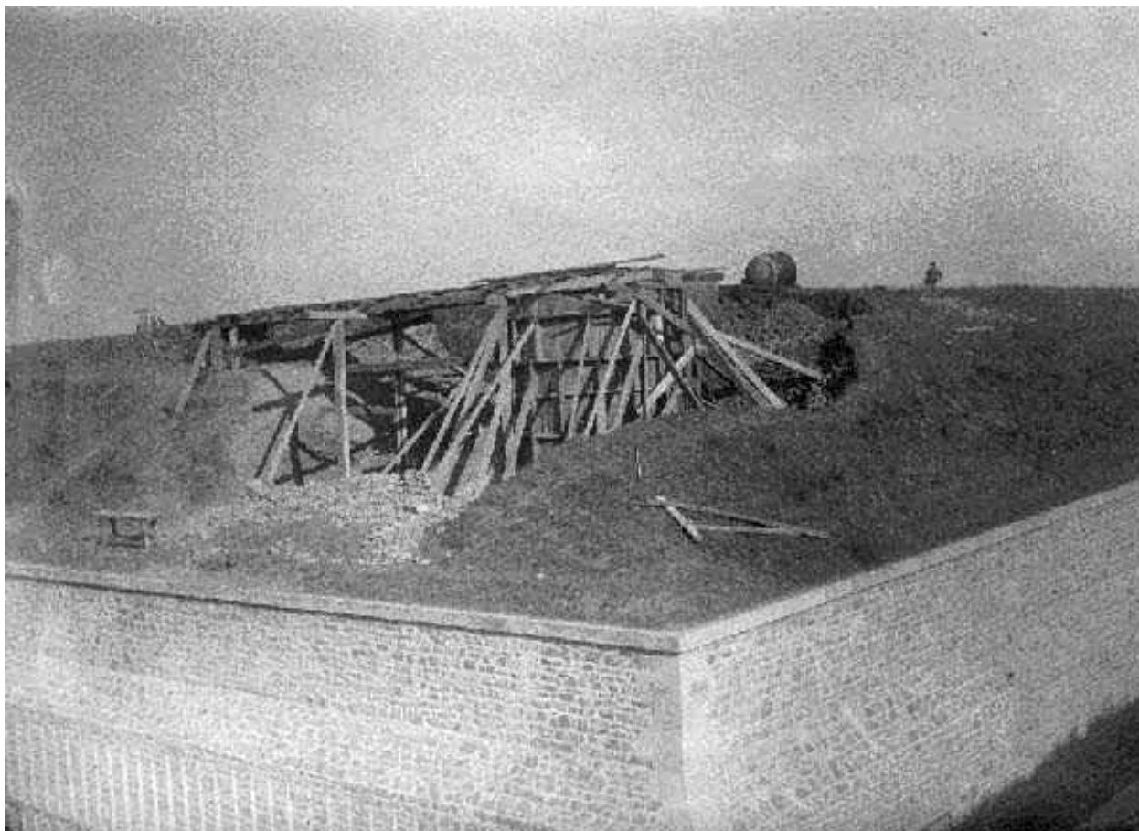
Vue du chantier de construction du réduit, vers 1902-1906 : coffrage du puits de l'une des deux tourelles pour canons de 75 mm
