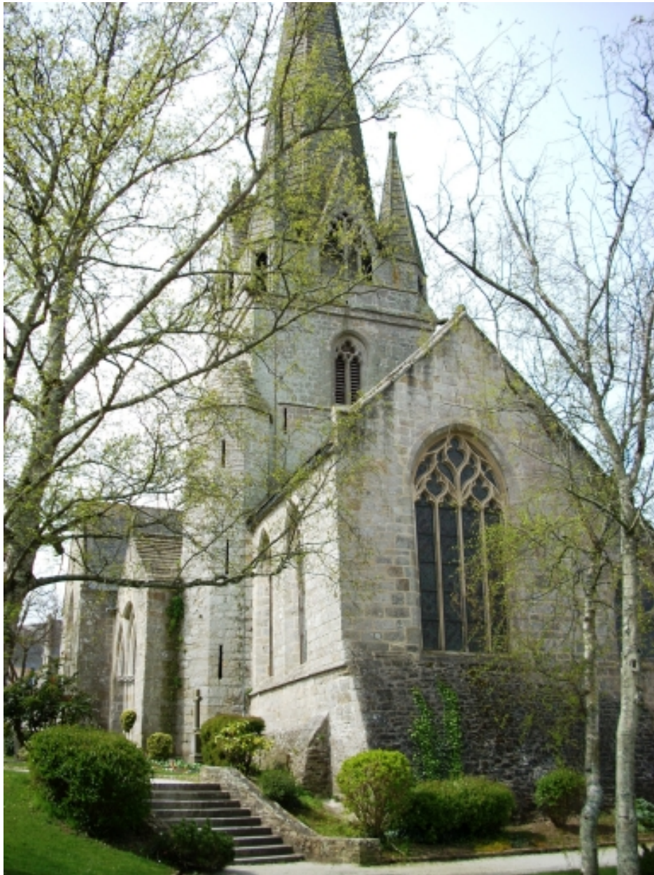
Rosporden, église paroissiale Notre-Dame : vue générale sud-est
