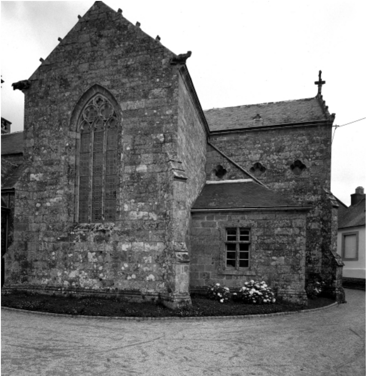
Quéménéven, église paroissiale Saint-Ouen : façade sud, partie est, état en 1972
