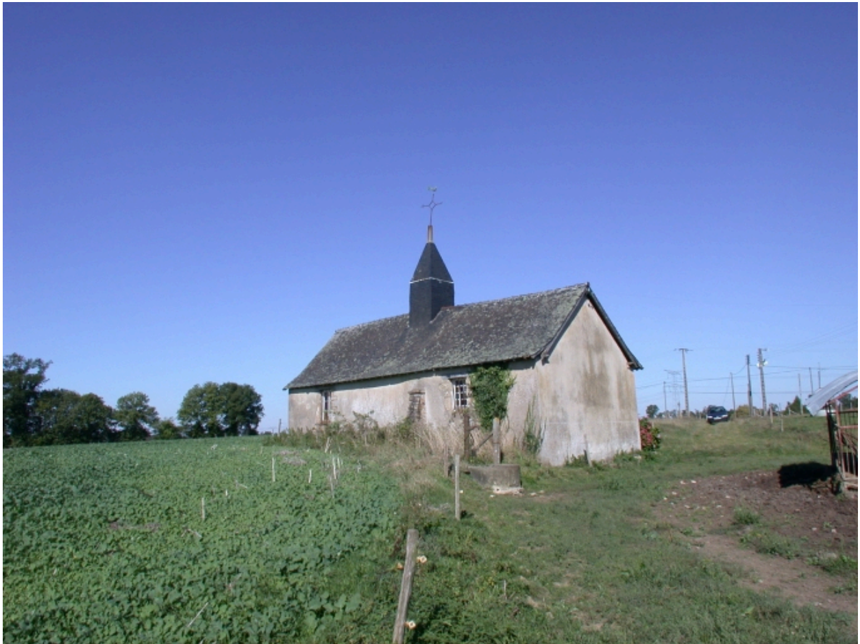
Vue générale nord
