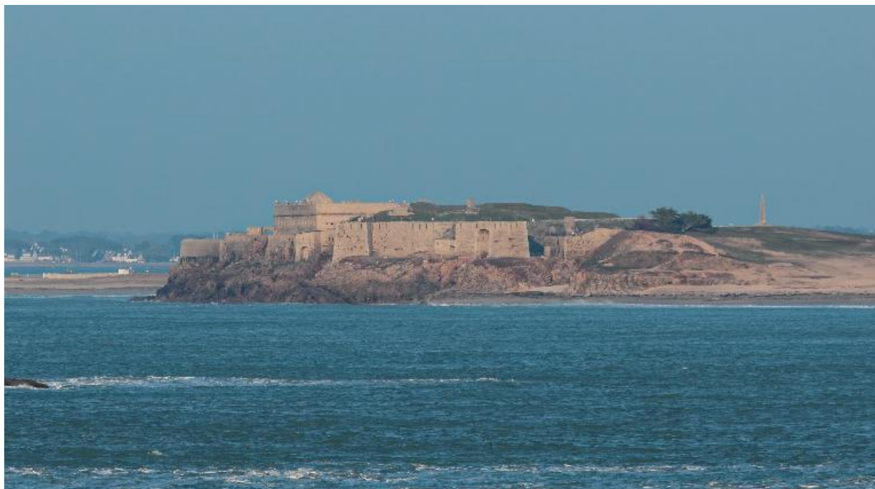
Saint-Pierre-Quiberon, fort de Penthievre, vue depuis le sud-ouest.
