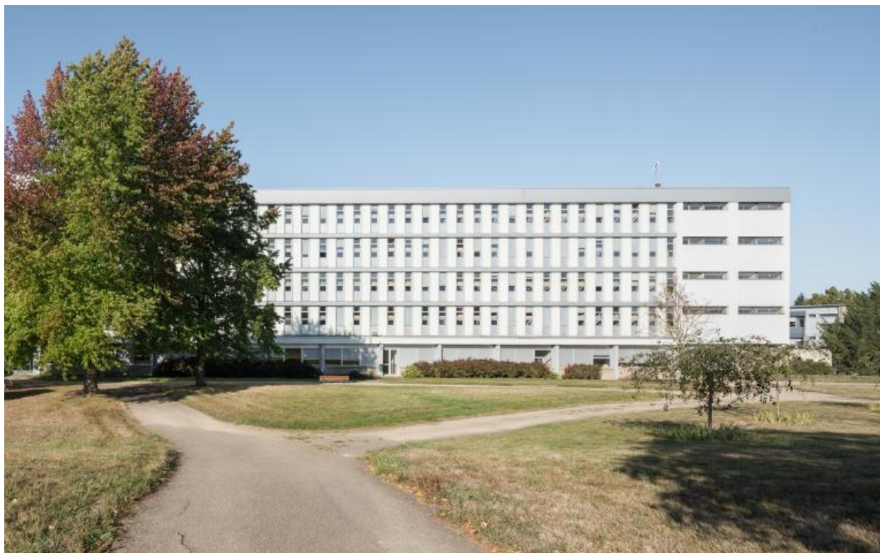
Bâtiment G, internat, façade est, vue partielle (côté nord). Louis Arretche et Jean Monge, architectes, plans 1959.
