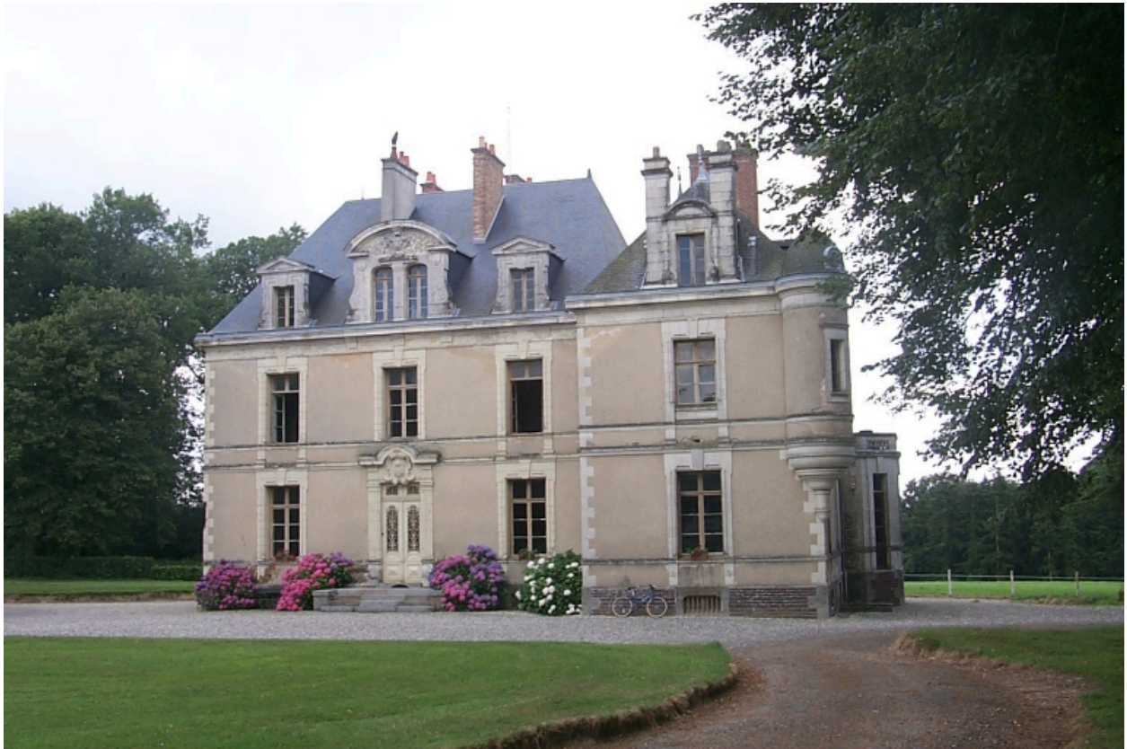
Façade sur le mail : vue générale nord-ouest
