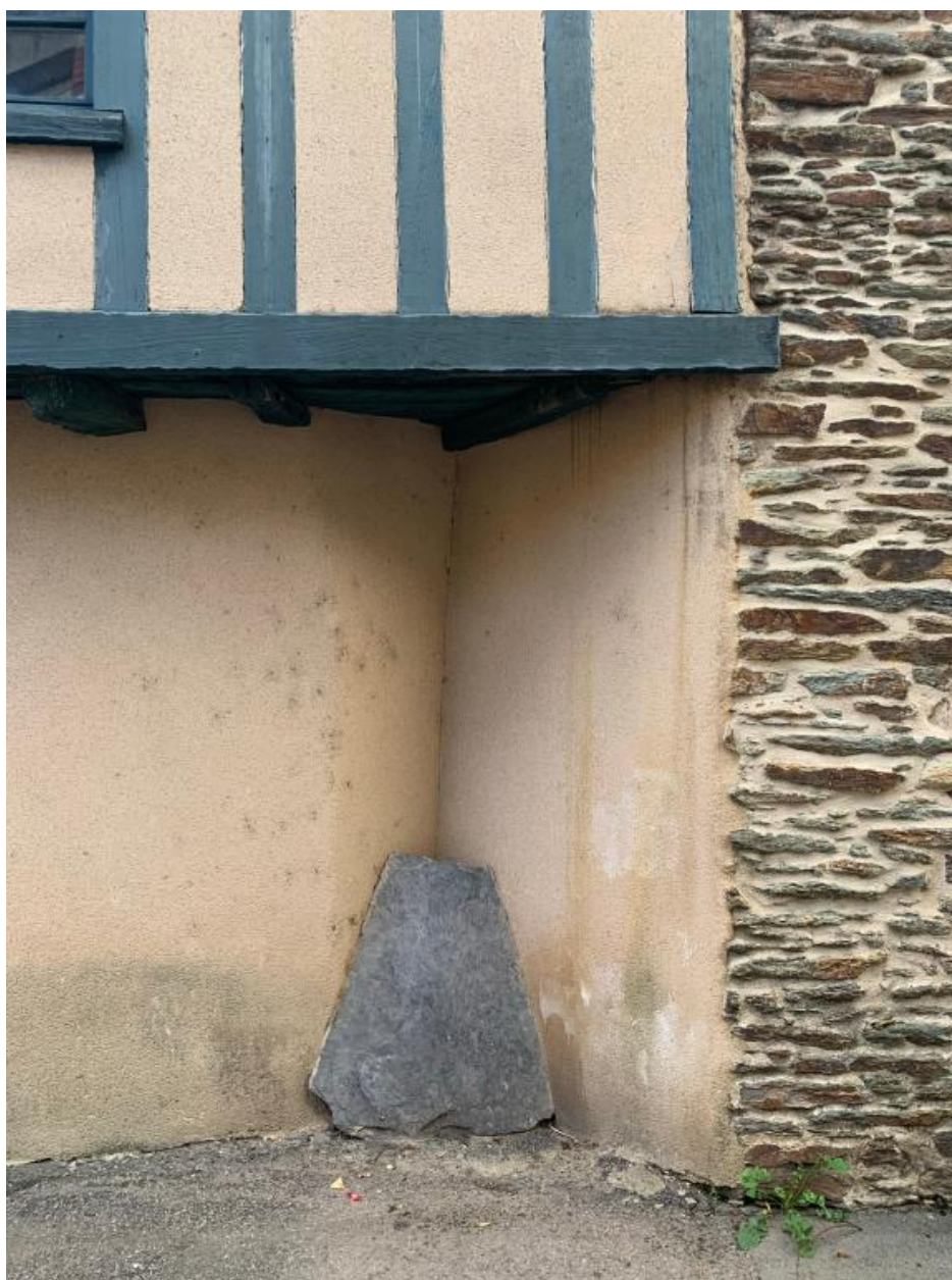
Elévation ouest, détail de l'encorbellement
