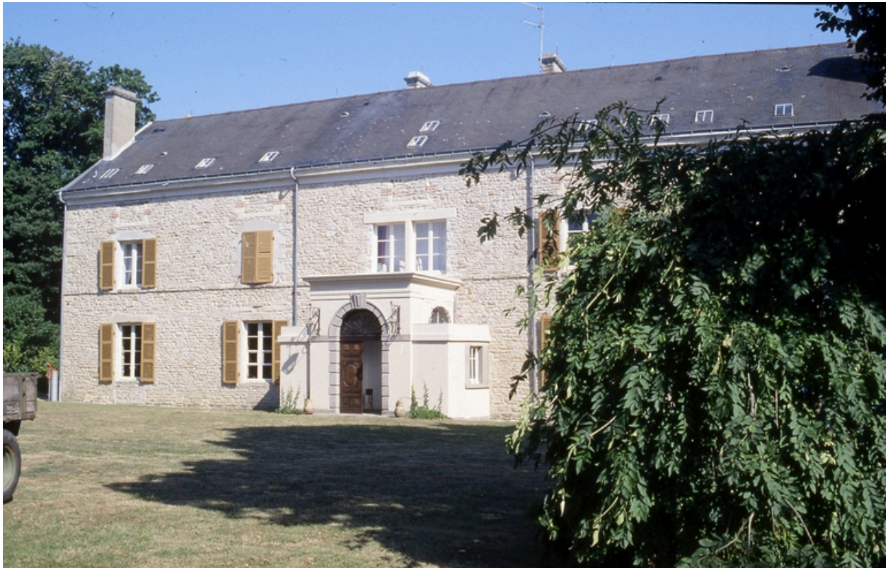
Elévation ouest, partie nord et chapelle
