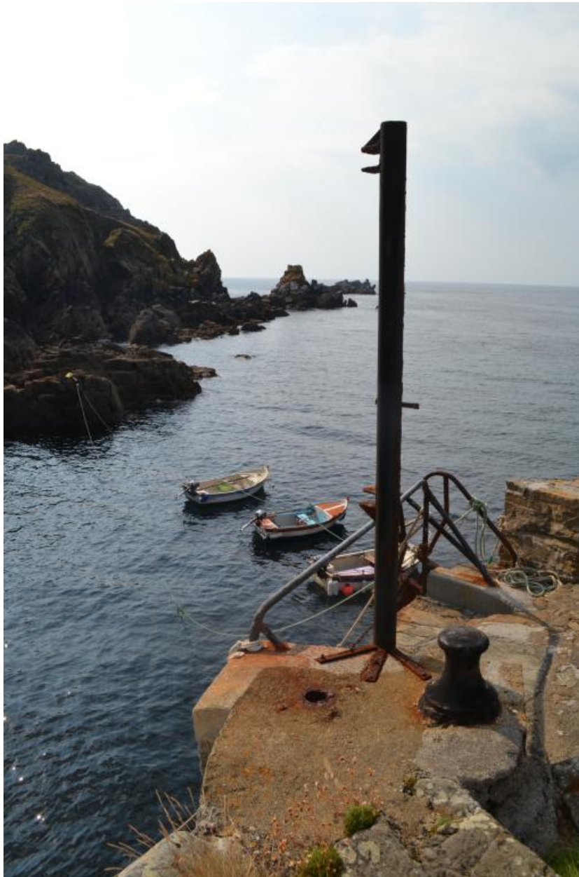
Débarcadère côté sud-ouest, mat de levage et échelle.
