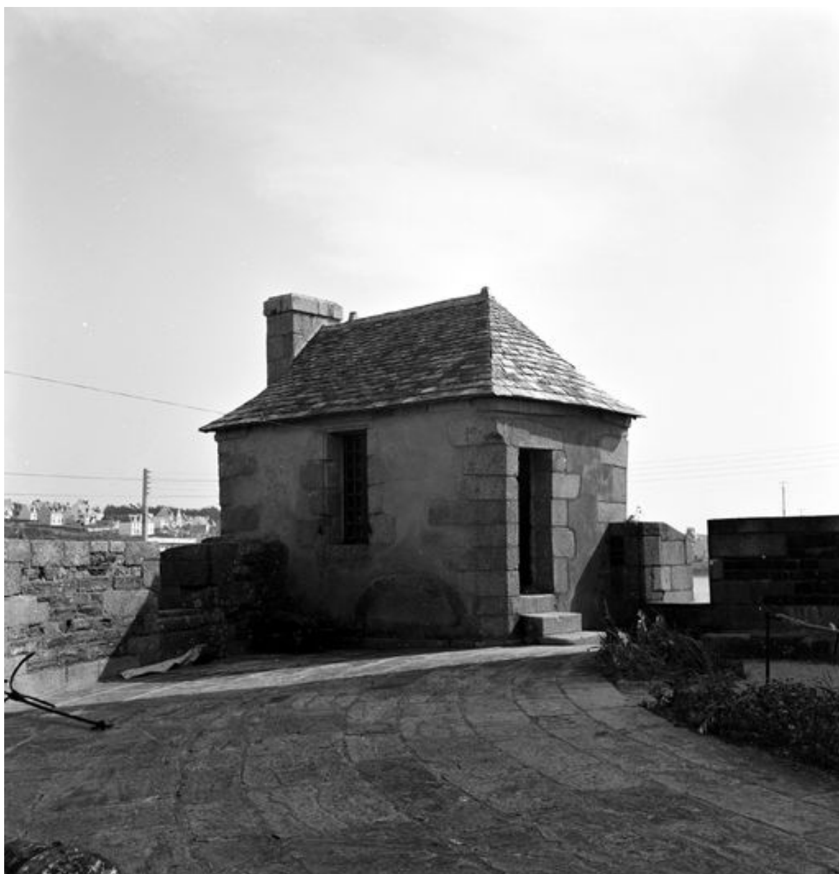
Vue du corps de garde défensif de la Tour Vauban en 1969
