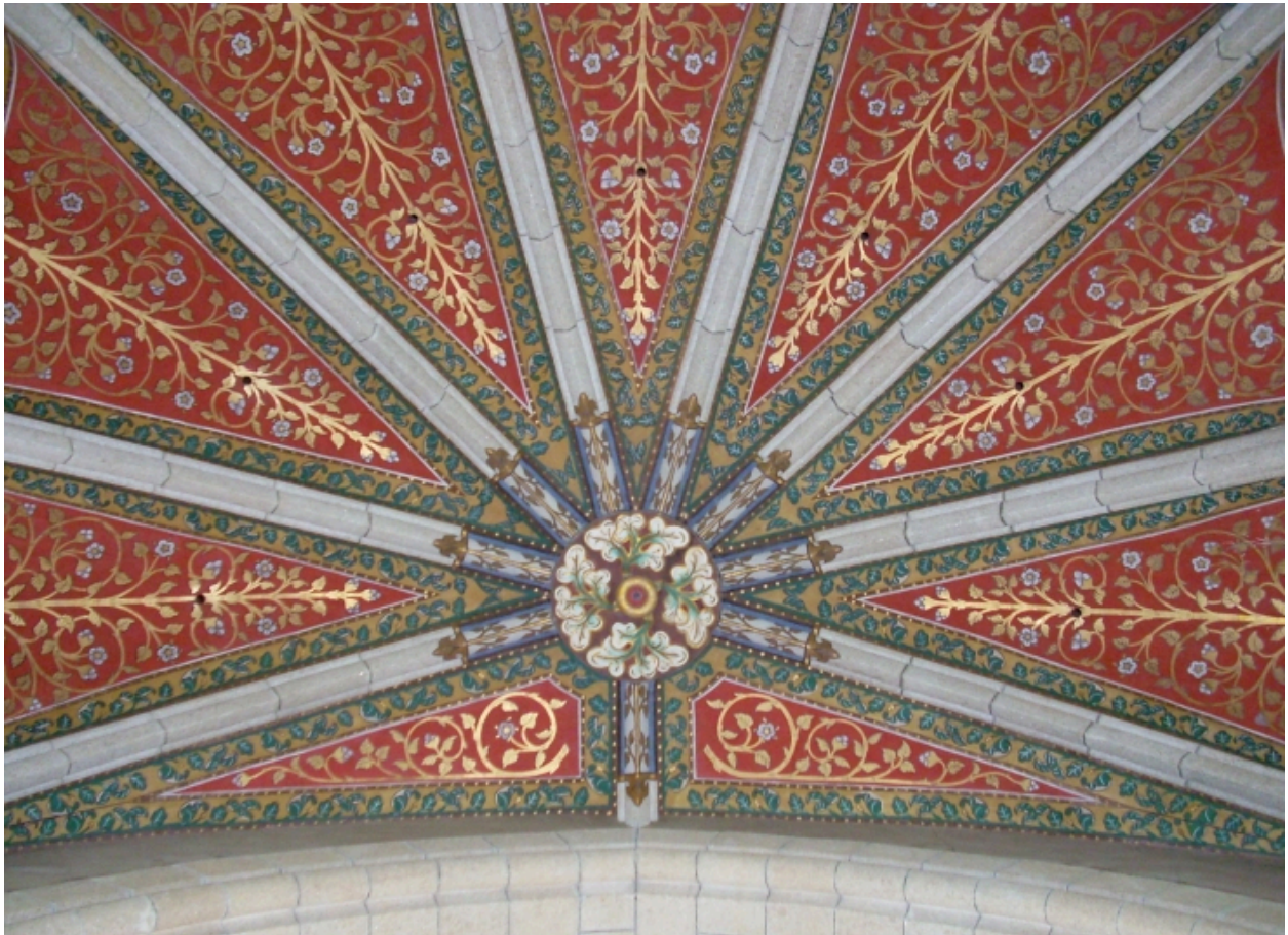
Pont-l'Abbé, chapelle du Sacré-Coeur : détail voissures du choeur
