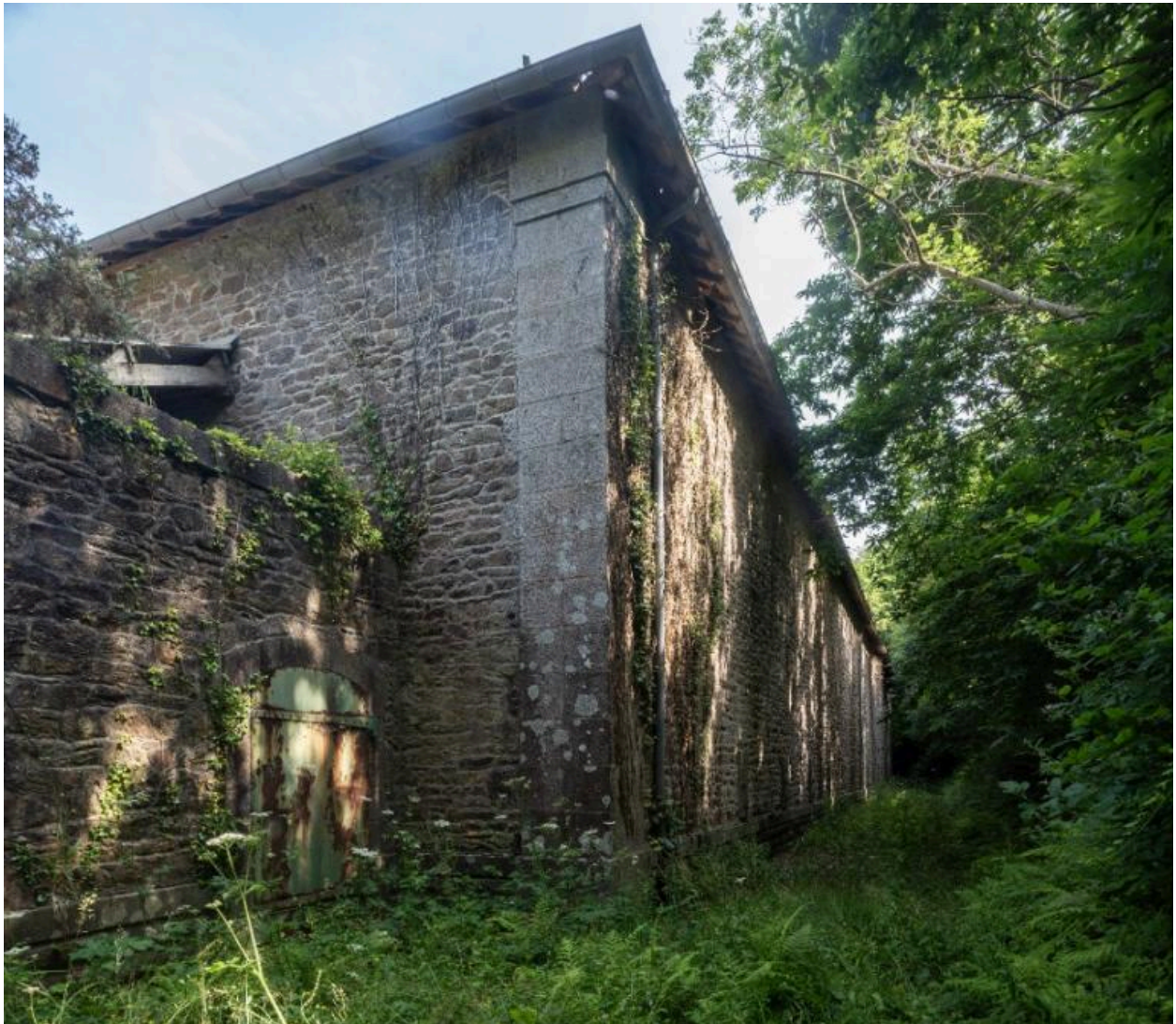
Vue de la poudrière n° 3 (P3) de la vallée de Kerhuon : élévation est (état en 2025). Les chaînes d'angle sont en pierre de taille de granite gris
