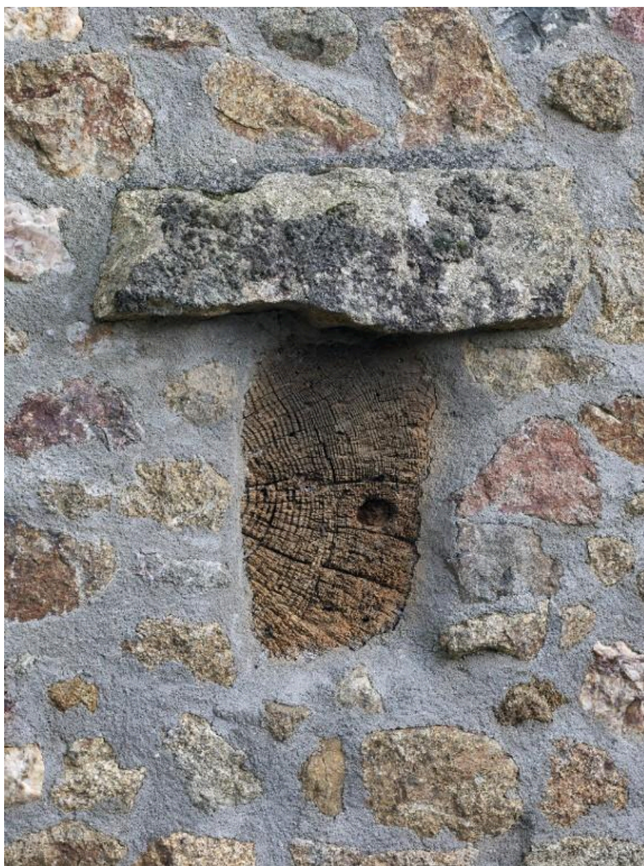
Pignon ouest. About de console de cheminée protégé par un larmier
