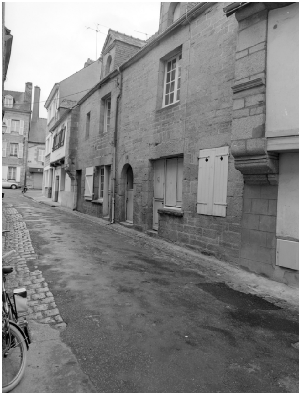
6-8 rue du Perroquet, vue générale des façades.
