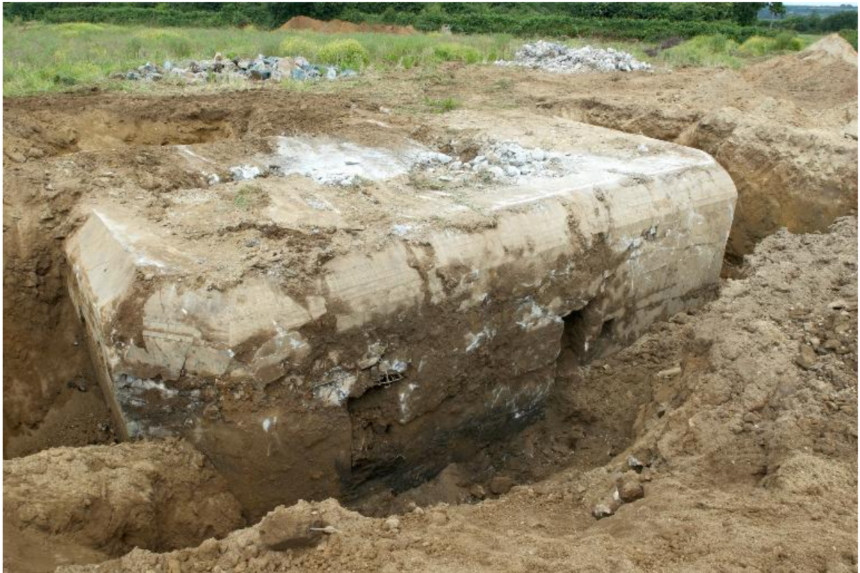
Déconstruction d'un bunker de type 502
