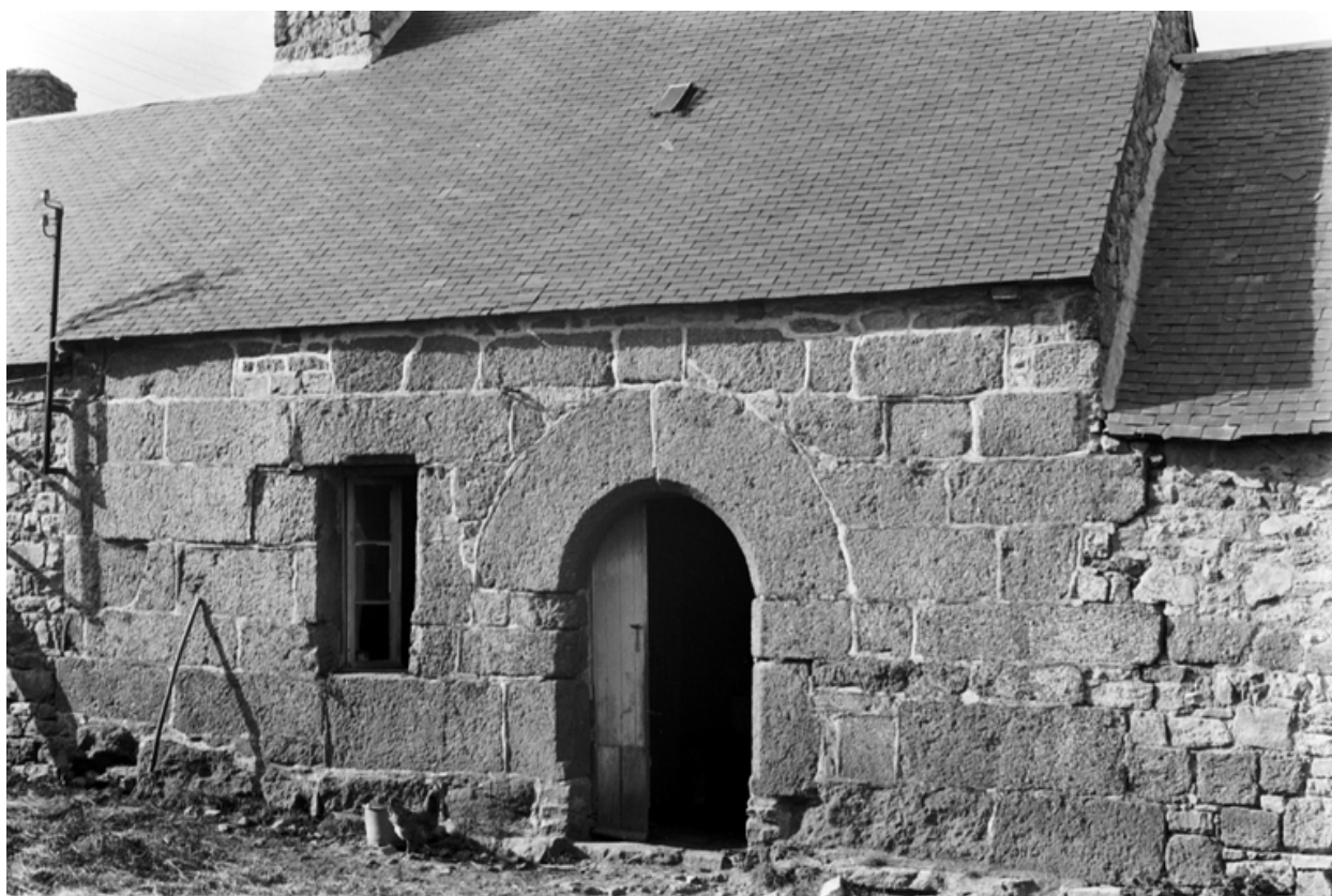
Maison n°1 Penty (Kerautravezan) : vue générale de la façade
