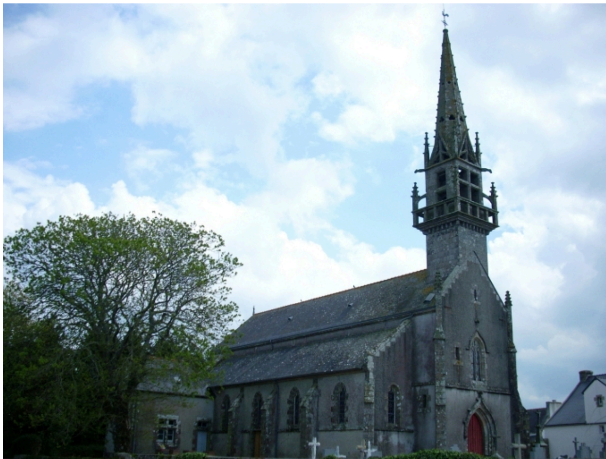
Guiler-sur-Goyen, église paroissiale Saint-Justin : vue générale nord-ouest
