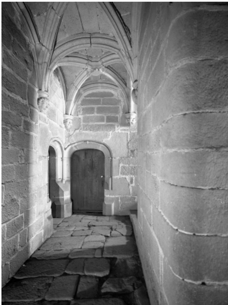
Escalier du 1er étage : vue axiale est ouest du palier
