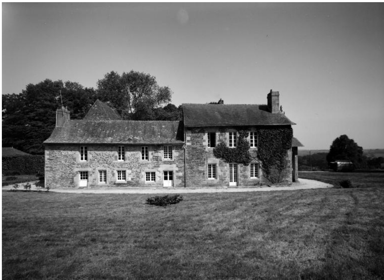
Vue générale de la façade sud
